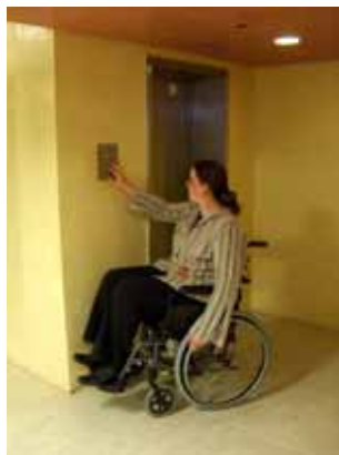
Ook de bedieningsknoppen van de lift moeten bereikbaar zijn.
