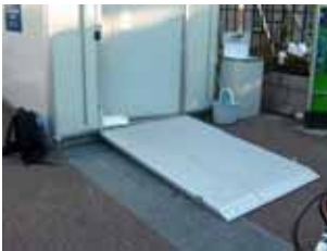
Het hoogteverschil bij deze toiletcabine is op een juiste manier overbruggd.
